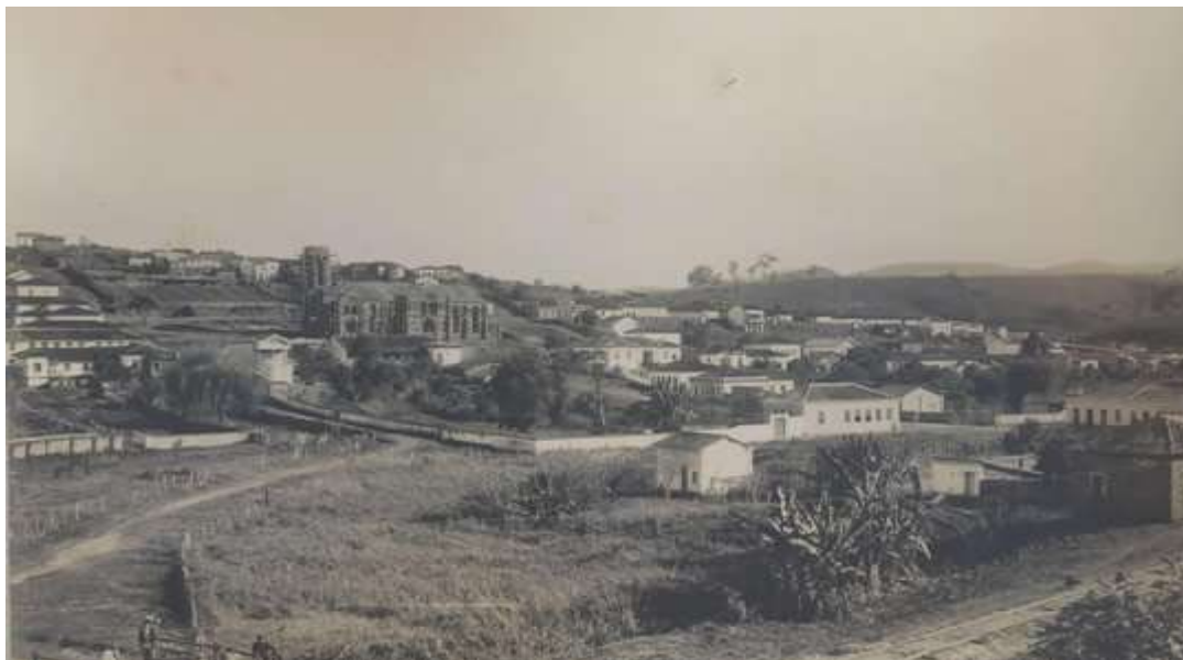
Figura 1 – Vista da região central de Jacutinga, ao fundo Igreja Matriz de Santo Antônio em construção, início do século XX.
