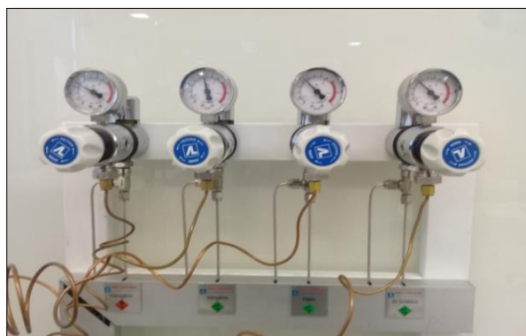
Figura 21. Linha de gases: Hidrogênio, Nitrogênio, Hélio e Ar sintético para cromatografia gasosa (Laboratório científico Agilent Technology ).
